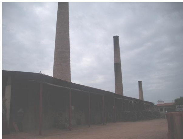
Figura 11: Fornos de uma fábrica de cerâmica com suas chaminés. Fonte: Francisco de Assis Mendes. Arquivo pessoal, 2011.
